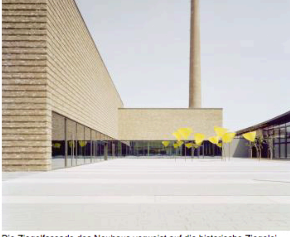
Die Ziegelfassade des Neubaus verweist auf die historische Ziegelei
