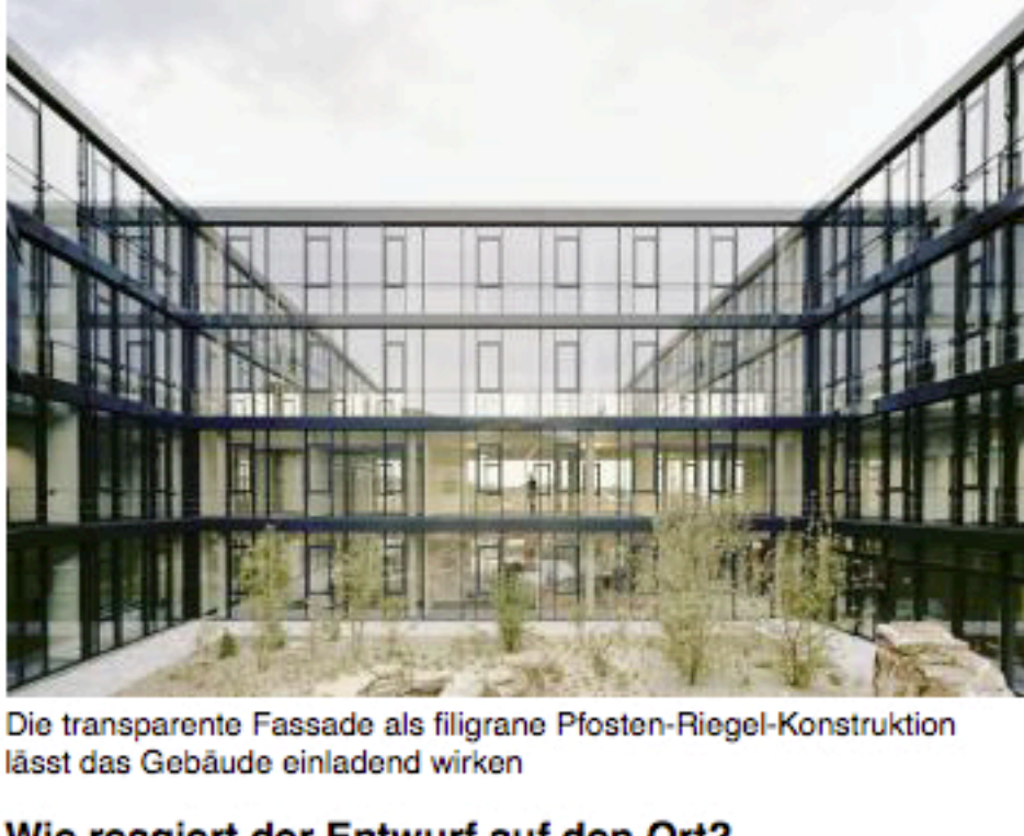
Die transparente Fassade als filigrane Pfosten-Riegel-Konstruktion lässt das Gebäude einladend wirken
